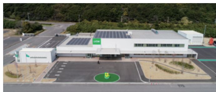
厚生棟の屋上に設置された太陽光パネル
