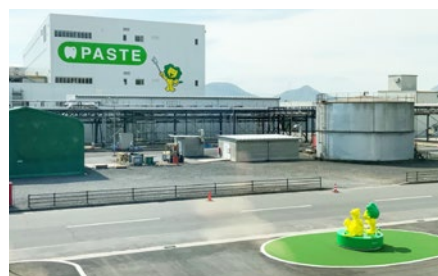
2021年7月稼働 坂出ハミガキ工場
