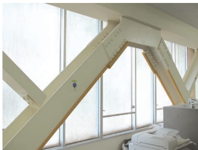
耐震補強した研究所の居室
