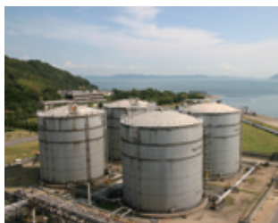
ライオンケミカル(株)の 認証油貯蔵タンク
