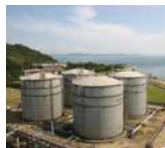
認証油貯蔵タンク
