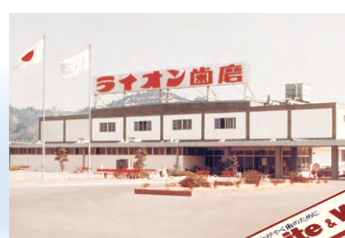
小田原工場竣工 (生産体制の増強)
