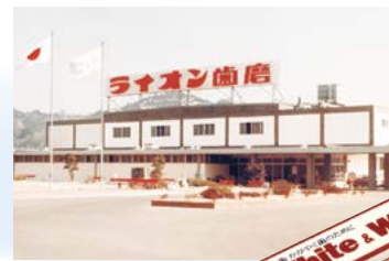
小田原工場竣工 (生産体制の増強)
