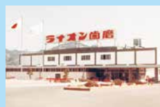
小田原工場竣工 (生産体制の増強)
