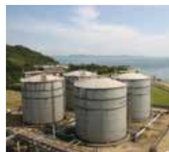
認証油貯蔵タンク
