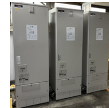
千葉工場 温水ヒートポンプ
