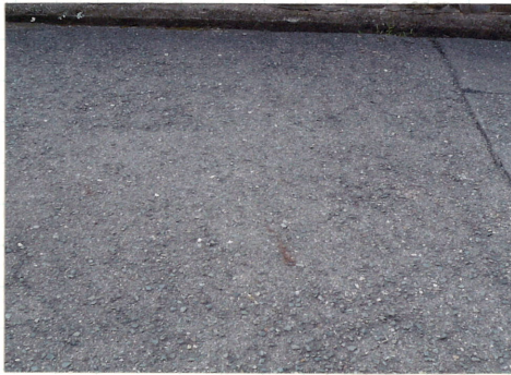
アスファルト
