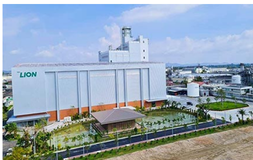
タイライオン新乾燥塔建屋の外観
